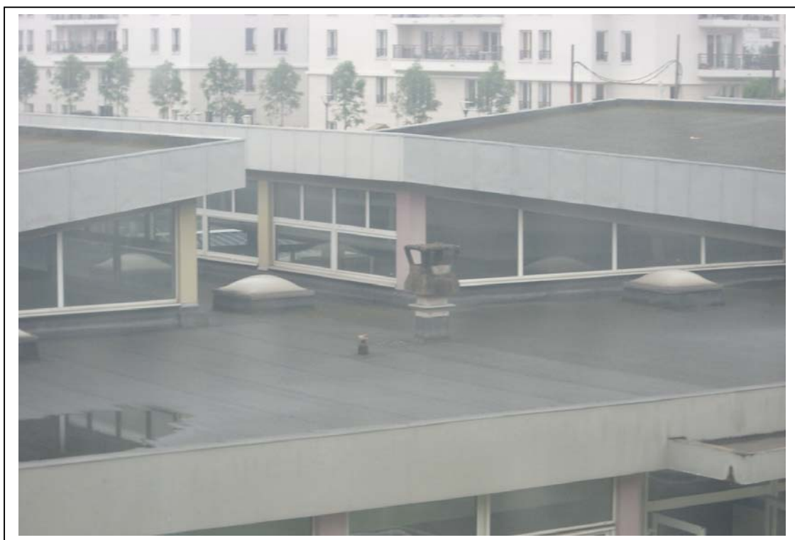
Vue extrémité de cheminée en fibrociment sur toiture
