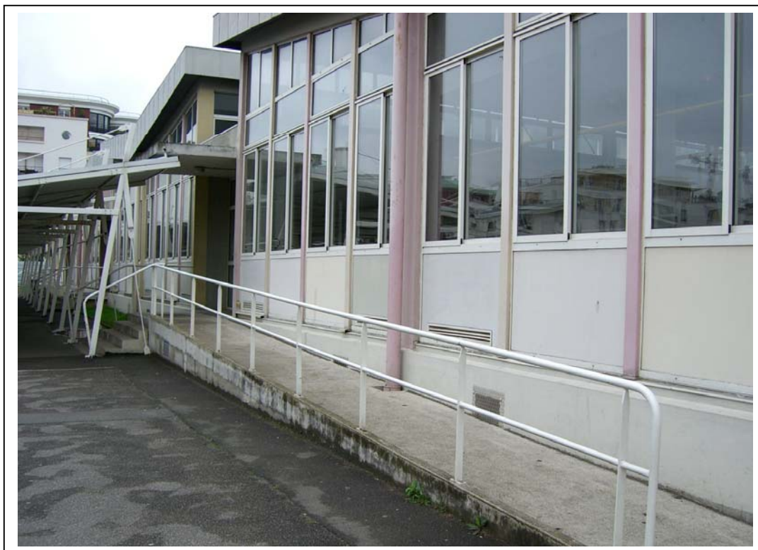
Vue des panneaux de façade en fibrociment peint
